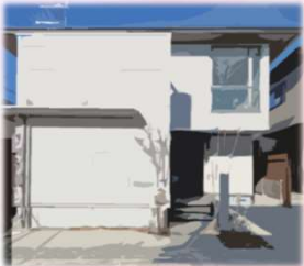
CS鶴ヶ島 鉄骨/1棟
