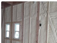
性能をアップさせた発泡断熱で建物を高気密高断熱化
